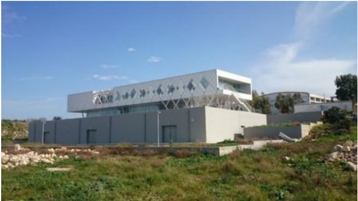
Εικόνα 1: Η κτηριακή υποδομή του IPPL στο Ρέθυμνο Κρήτης.
